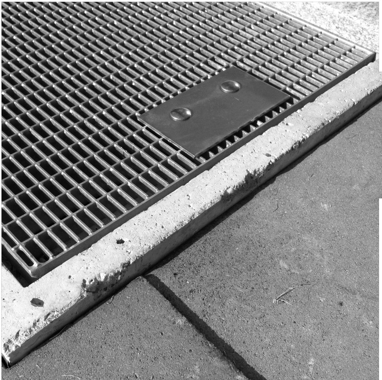
GITTERROST-SICHERUNG BLASER **GS**
